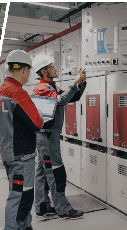
Greenhouse ПС 110/10 кВ «Гринхаус»
